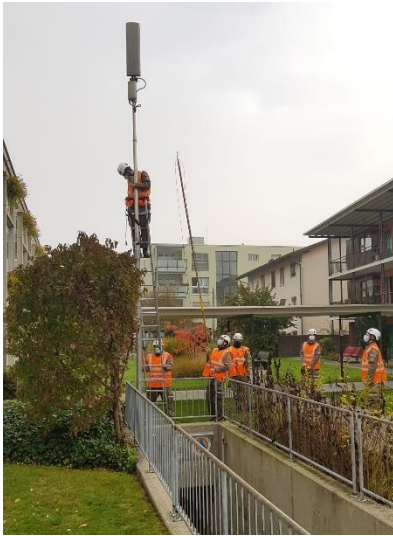
Leitungsbau ab KP Niederbipp
