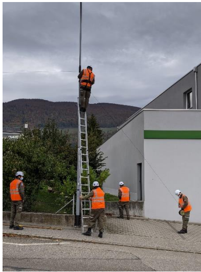
Leitungsbau entlang der Strasse
