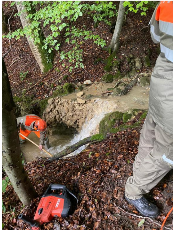
Kalknasen mit Abbaugeräten entfernen
